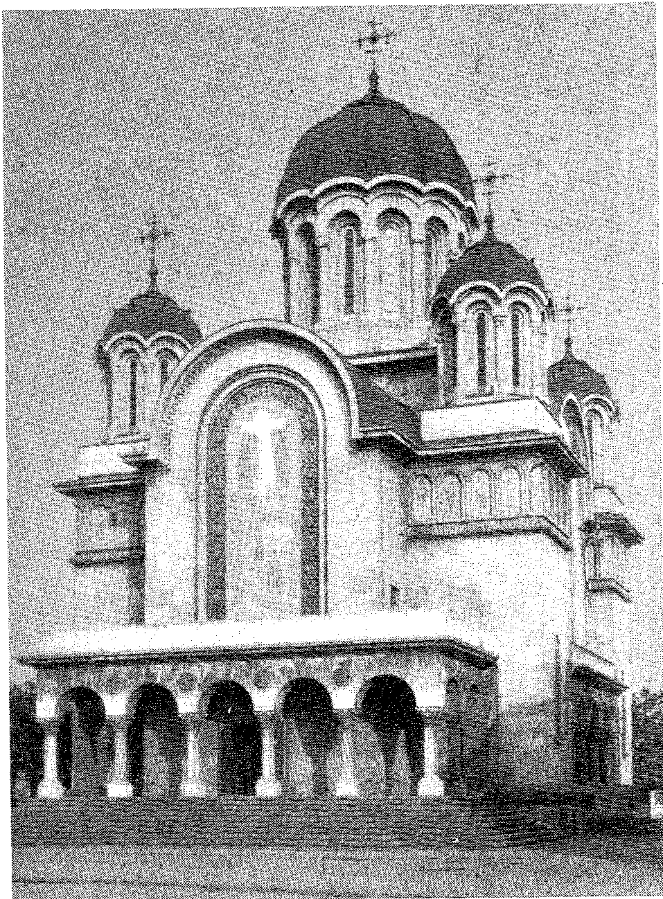
Biserica Sf. Împărați Constantin și Elena din Hunedoara (1938–1946), în stil bizantin, cu elemente din arhitectura munteană, construită din marmură din carierele locale.
