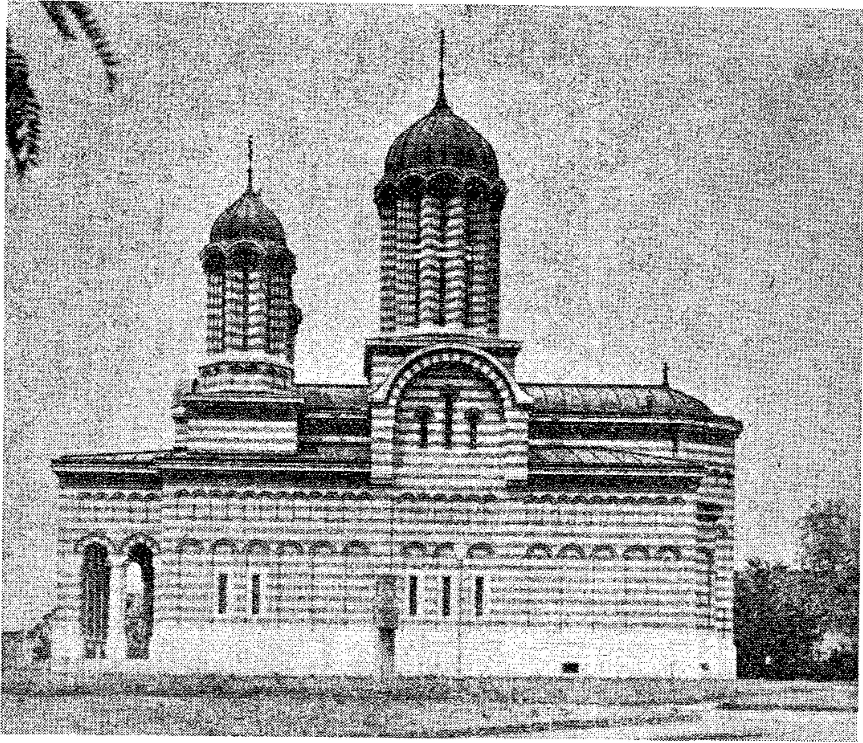
Biserica Sf. Dumitru din Craiova, azi catedrală mitropolitană, ridicată între anii 1889–1933 (inițial sub conducerea arhitectului André Lecomte du Nouy), pe locul vechii biserici rezidită de Matei Basarab în 1651.
