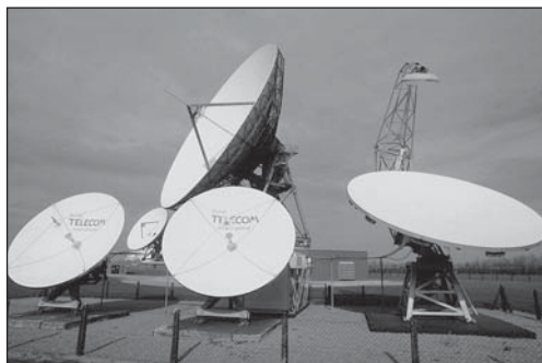
Наземные ретрансляционные станции, образующие радиолинии
