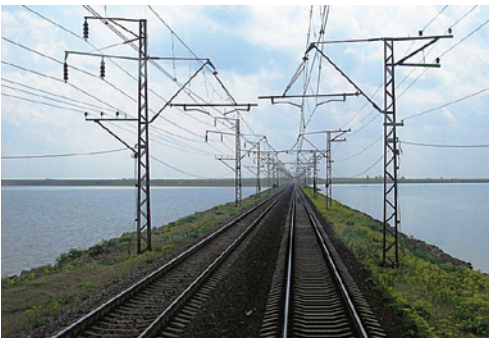
Fig. 3.12. Linii ferate flancate de piloni electrici
