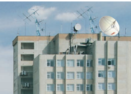
На крыше антенны.
