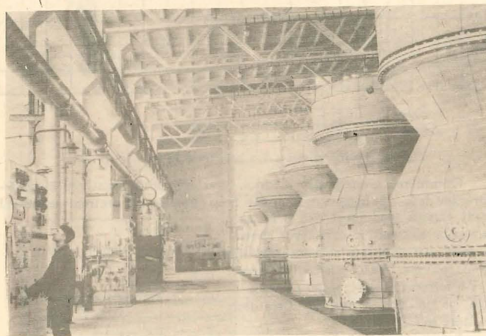
Hala de oxidare a amoniacului de la Combinatul de Îngrășăminte cu Azot din Roznov
