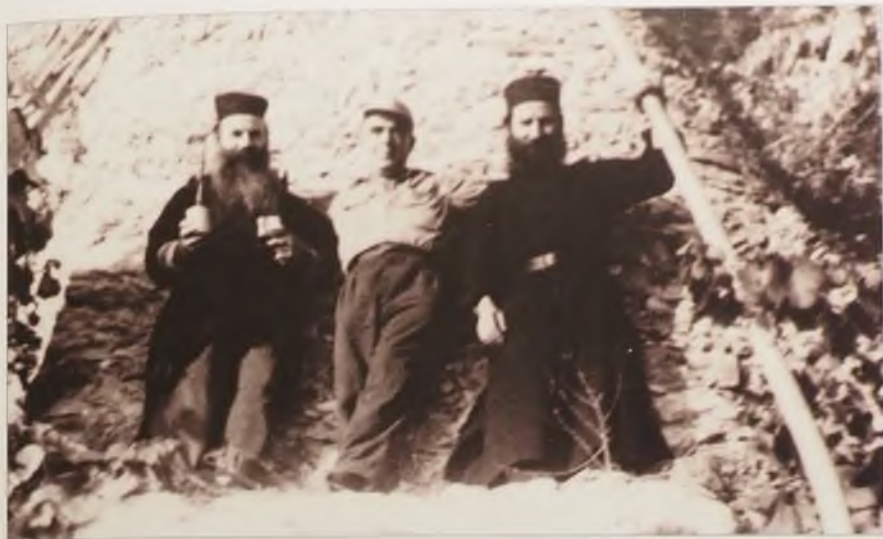
22 și 23. Gheronda Iosif împreună cu Gheronda Macarie din obștea Chirileilor (în stânga) și alții reparând instalațiile de apă de la Noul Schit (în anii '60)
