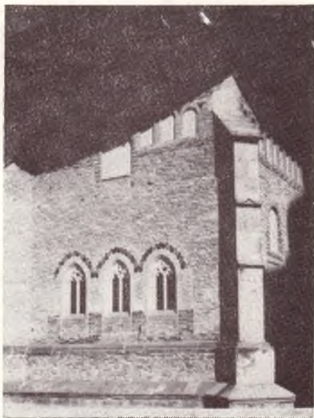
Fațada de vest.
