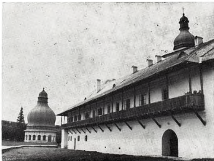
Agheazmatarul și latura de sud a incintei după restaurarea din 1960.
