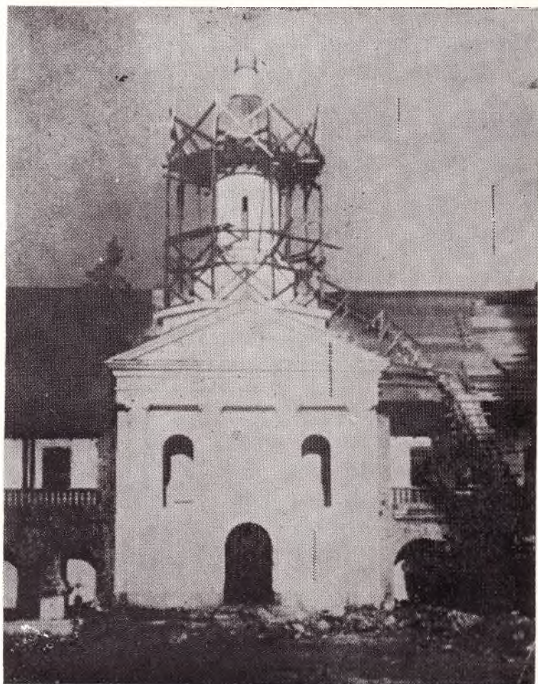
Biserica Sf. Gheorghe în perioada lucrărilor de reconstruire.
