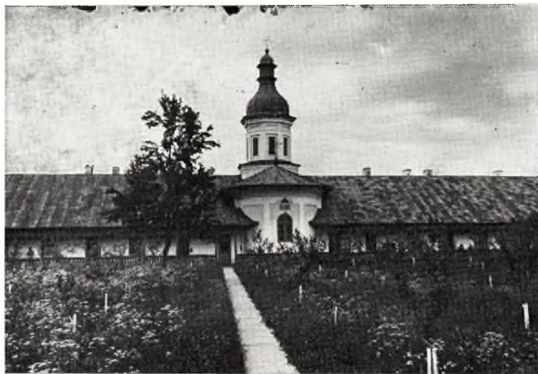
Biserica de la bolniță și laturile chiliilor în cadrul cărora este amplasată.
