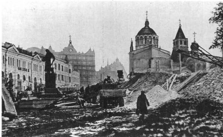
Разборка Китайгородской стены и примыкавших к ней ц. Владимирской иконы Божией Матери, часовни вмч. Пантелеимона, Никольской башни и др. в связи со строительством Московского метрополитена. Фотография кон. 30-х гг. XX в.
