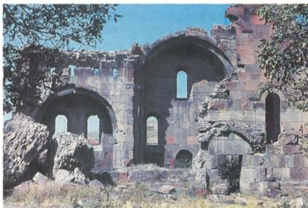
пространства, шириной пролетов сводов и купола. Обычным явлением было устройство купола пролетом до 9 м, в отдельных храмах ширина подкупольного квадрата составляла 14,05 м (Артик), 12,2 м (Мастара). Подкупольный переход осуществлялся системой тромпов,
