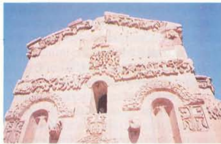
Церковь Сурб Хач. Фрагмент зап. фасада
