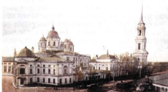
Архиерейский двор. Архит. Дж. Кваренги. 1784–1787, 1828 (колокольня) гг. Фотография. Нач. XX в.
