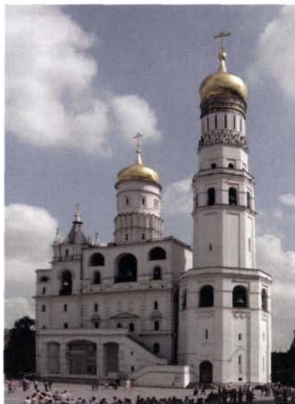
Церковь-колокольня прп. Иоанна Лествичника (1505–1508) и Успенская звонница (1814–1815)
