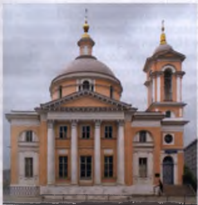
Церковь вмц. Варвары на Варварке в Москве. 1796–1804 гг. Архит. Р. Р. Казаков. Фотография. 2011 г.
