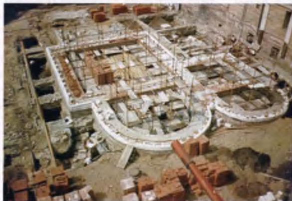
Завершение раскопок и начало кладки фундамента Казанского собора. Фотография. 1990 г.
