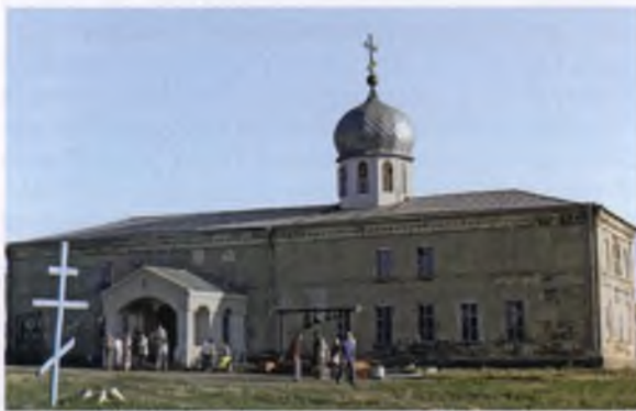
Церковь в честь иконы Божией Матери «Всех скорбящих Радость» и место разрушенного Троицкого собора. Фотография. 2008 г.
