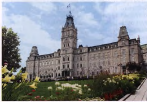
Здание квебекского парламента. 1877–1886 гг. Архит. Э. Таше
