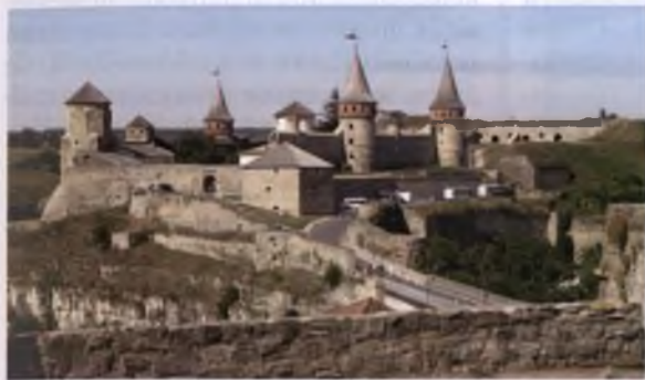
Крепость в Каменце-Подольском. Фотография. 2008 г.
