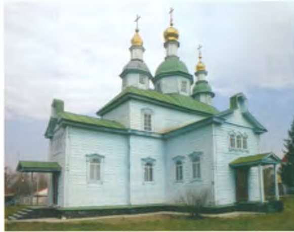
Церковь св. Онуфрия в с. Липовый Скиток. 1705 г. Фотография. 2012 г.
