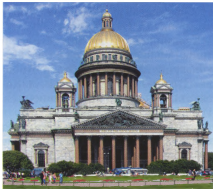
Собор св. Исаакия Далматского в С.-Петербурге. 1818–1858 гг.
