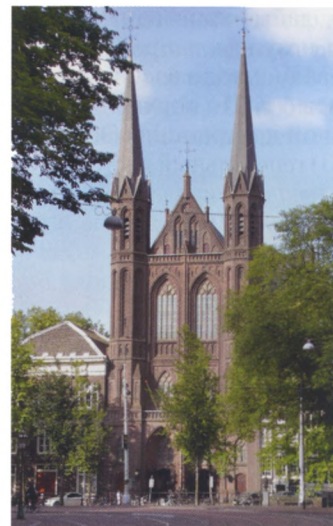
Церковь св. Франциска Ксаверия в Амстердаме. 1881–1883 гг. Архит. А. Тене
