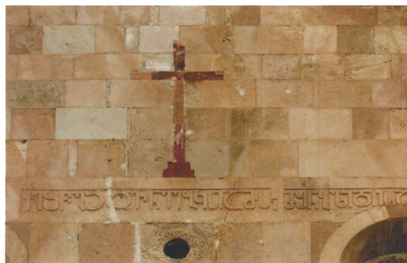
Фрагмент строительной надписи на вост. фасаде храма Кумурдо
