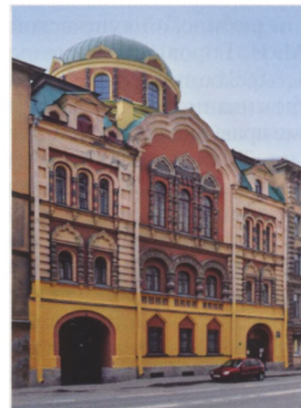
Подворье в С.-Петербурге. 1894 г. Фотография. 2013 г.
