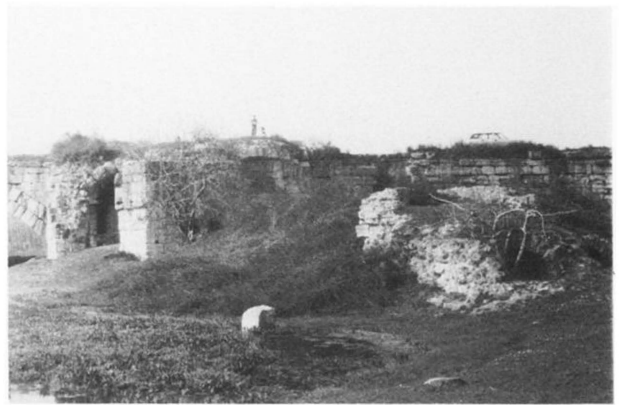
(d) Breakwater from south.
