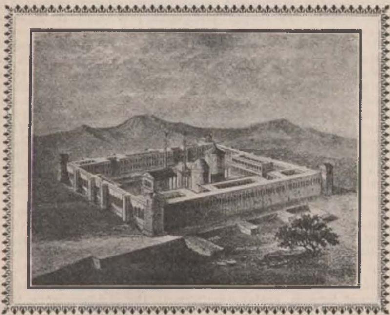
Marele palat al tiranului împărat Dioclețian (284—305), zidit în orașul Salona, (Dalmăția). Azi nu se mai cunosc de cât ruinele acelei zidiri.
