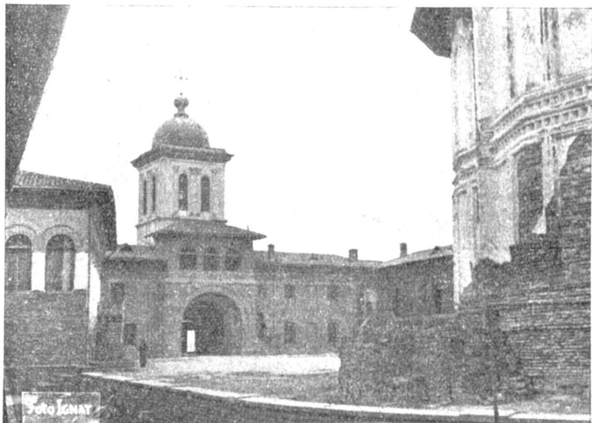
Clopotnița Mănăstirii Plumbuita văzută din interior, împreună cu o parte d.n. chiliile restaurate
