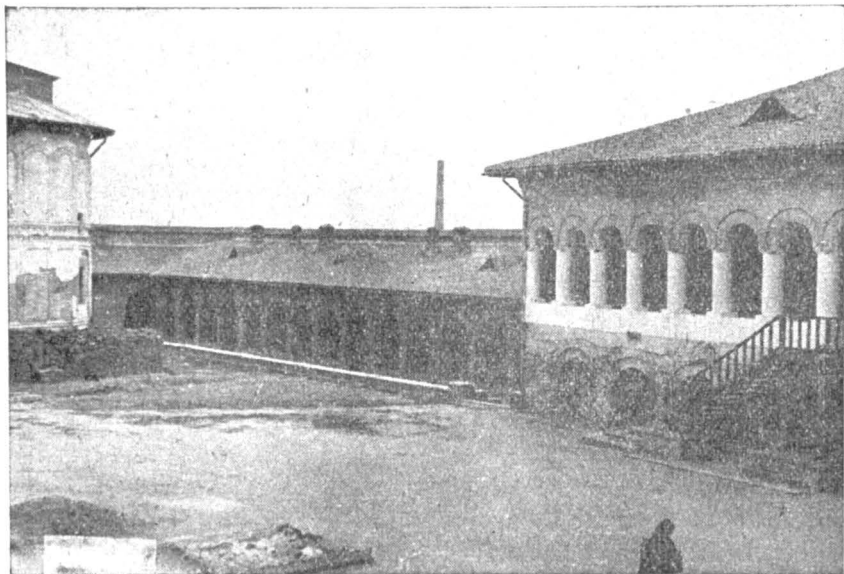
Arhondaricul și Stăreția dela Plumbuita, ale căror acoperișuri au fost refăcute.
