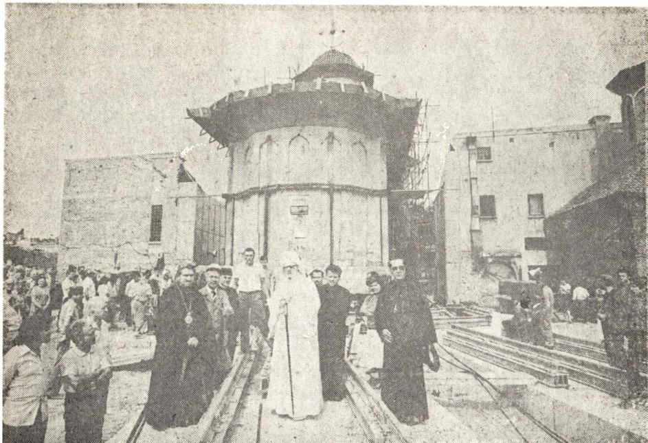
Deplasarea bisericii în linie dreaptă pe distanța de 245 m
