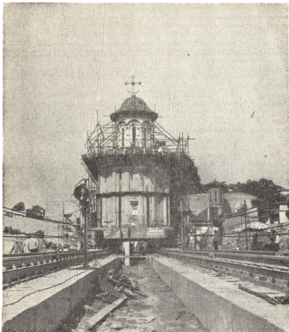
Calea de rulare a fost executată din elemente prefabricate
