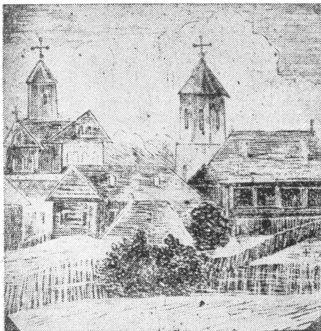
Minăstirea Cernica în 1794. Biserica și clopotnița construite de Cernica Vornicul în 1608 și reparate de sta-rețul Gheorghe în 1802.
