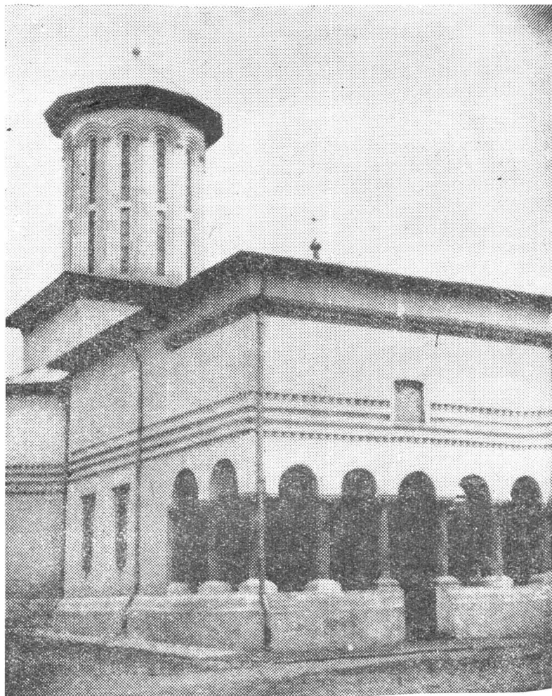
Fig. 1. — Biserica fostei Mînăstiri Rîmnicu-Sărat — vedere generală.
