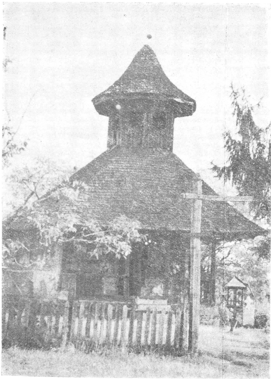
Fig. 2. — Biserica de lemn de la Glimbocata.
