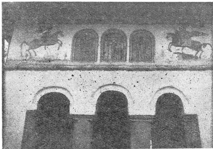
Fig. 7. Biserica din com. Profa, r. Vedea. Fațada principală
