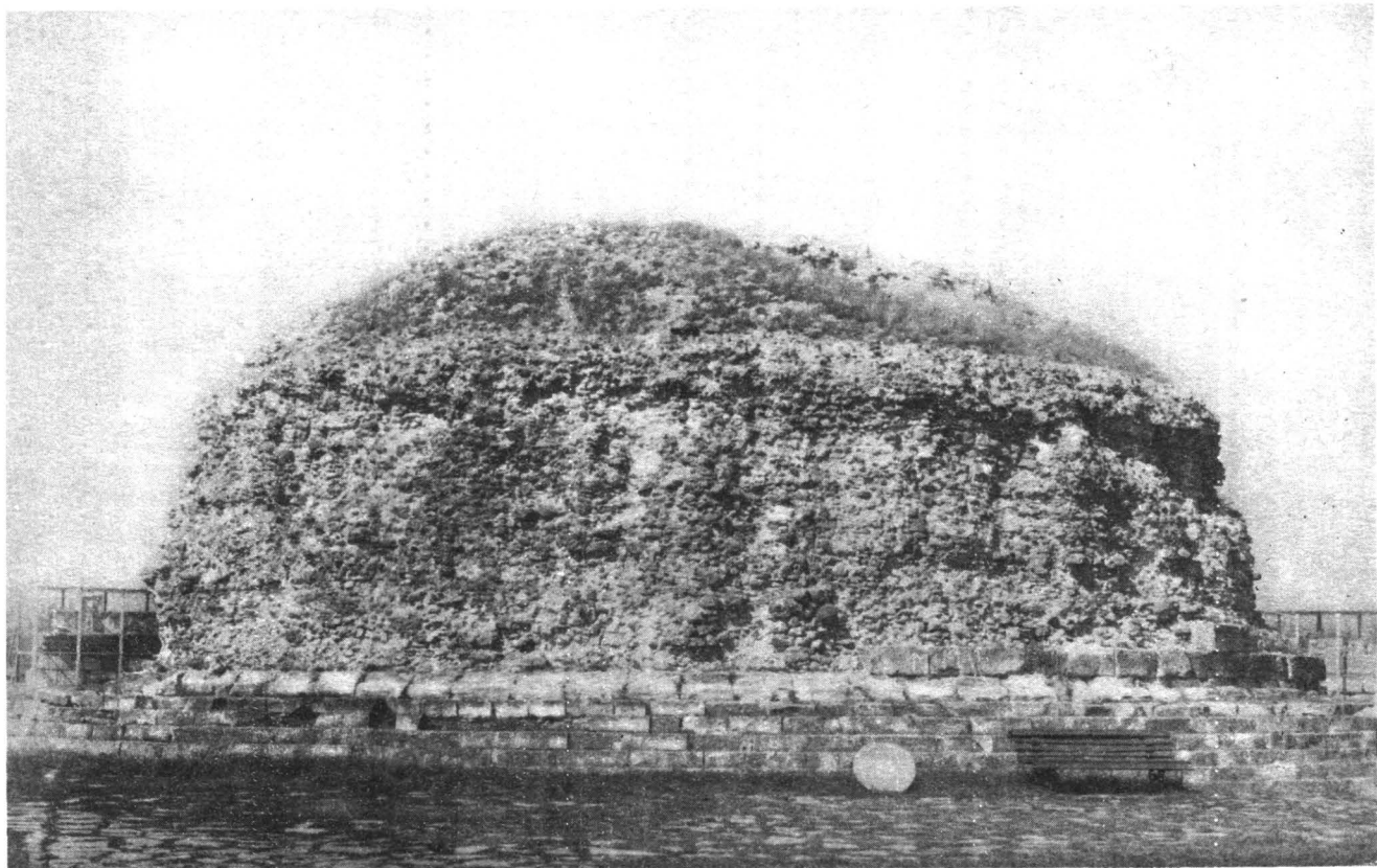
Fig. 1 – Nucleul monumentului înainte de restaurare
