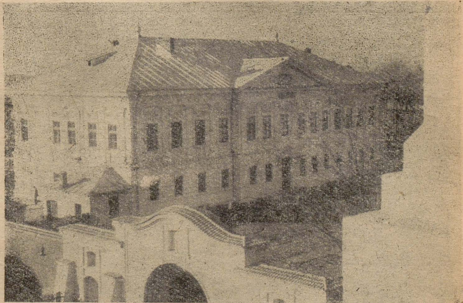
Fig. 7. — Seminarul și portalul de la intrare, zidit recent.
