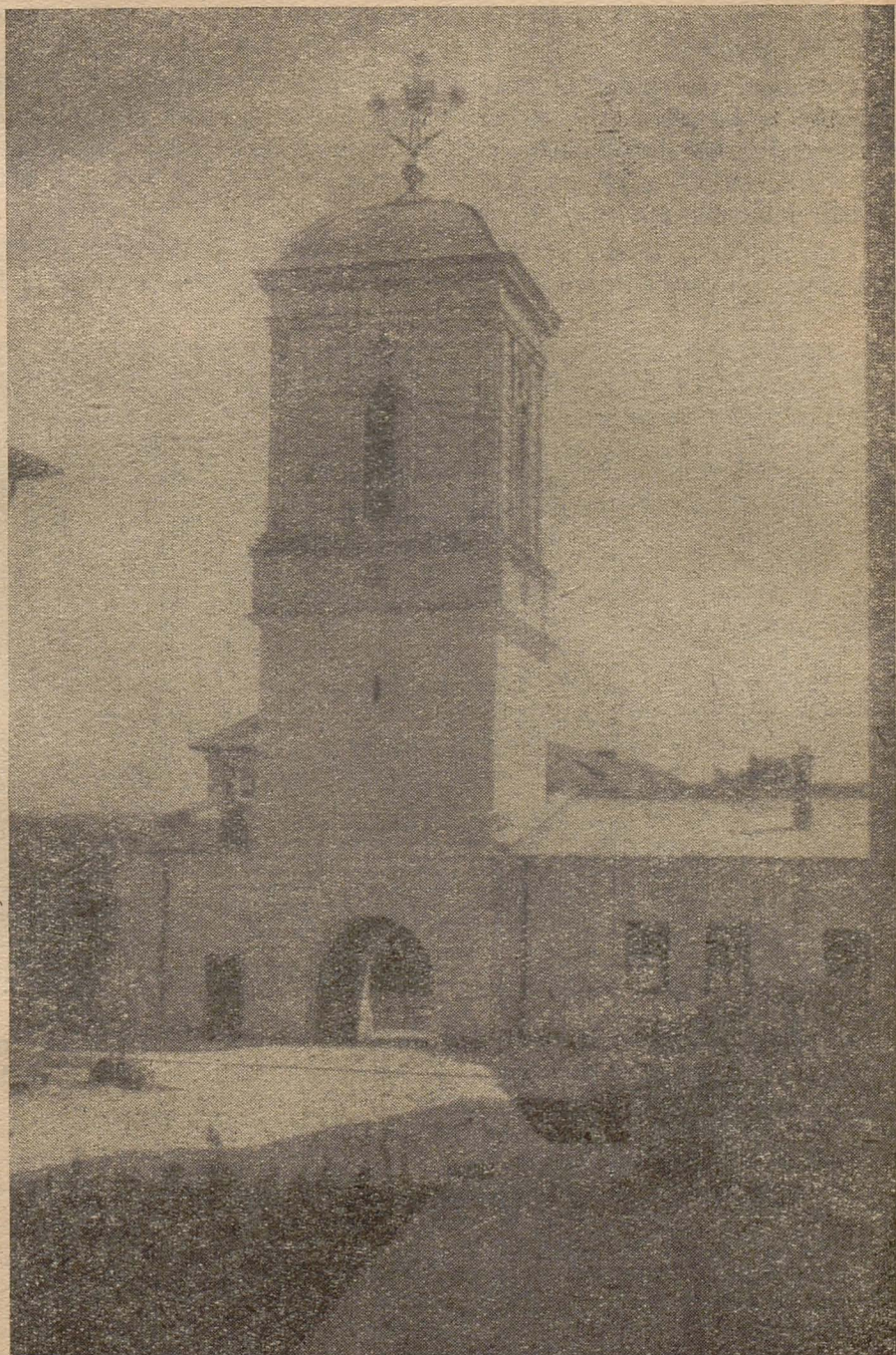
Fig. 9. — Clopotnița, vedere din curtea catedralei. https://biblioteca-digitala.ro / https://bibsinod.ro
