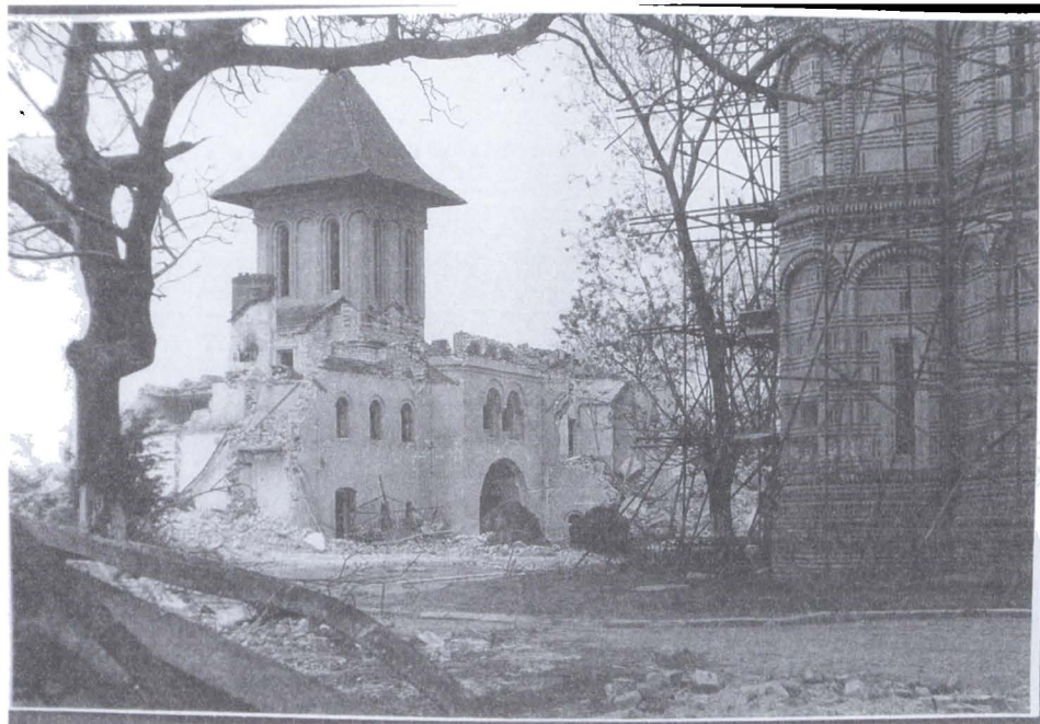
Dărâmarea aripii construite de arh. Cerchez, vedere din interiorul curții complexului (Sursa: ANIC, Fototeca , F III 1049)
