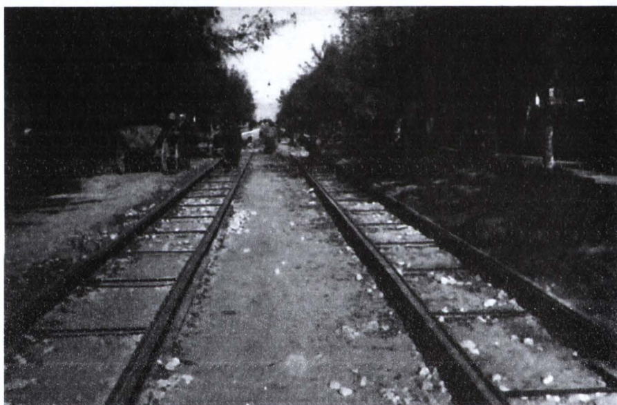
Figura 3. Montarea șinelor de tramvai de tip Phoenix pe Strada Carol între străzile Tudor Vladimirescu și Decebal, în toamna lui 1943. Fundația șinelor a fost realizată din piatră spartă și nisip cilindrate, iar distanța de 1 m a fost menținută cu bare de ecartament.
