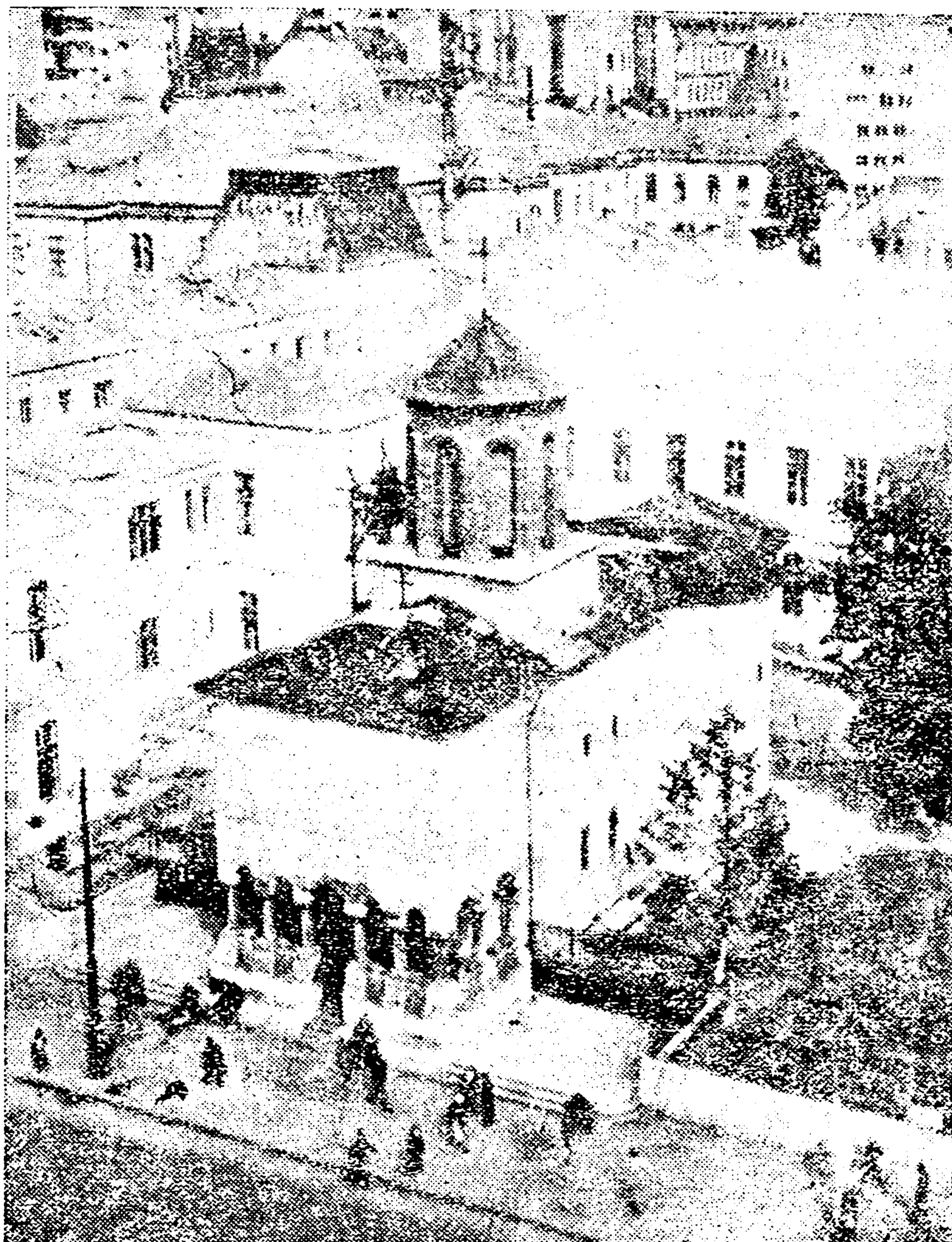
Biserica Colței din București, în timpul lucrărilor de restaurare din vara acestui an.
