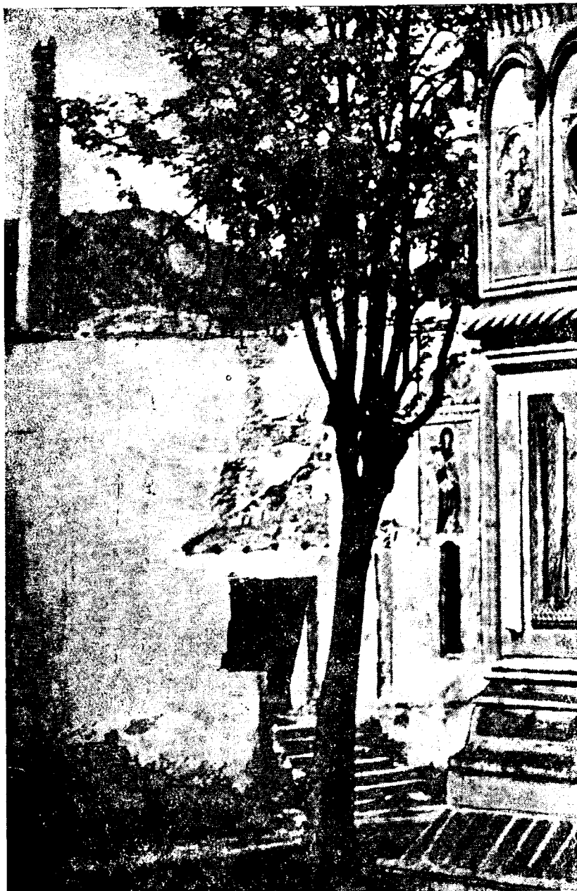
Mănăstirea Argeș. Intrare la sudul paraclisului. Fotografie de Carol Popp de Szathmáry (După Albumul Național) [art.: Etape de construcție...]
