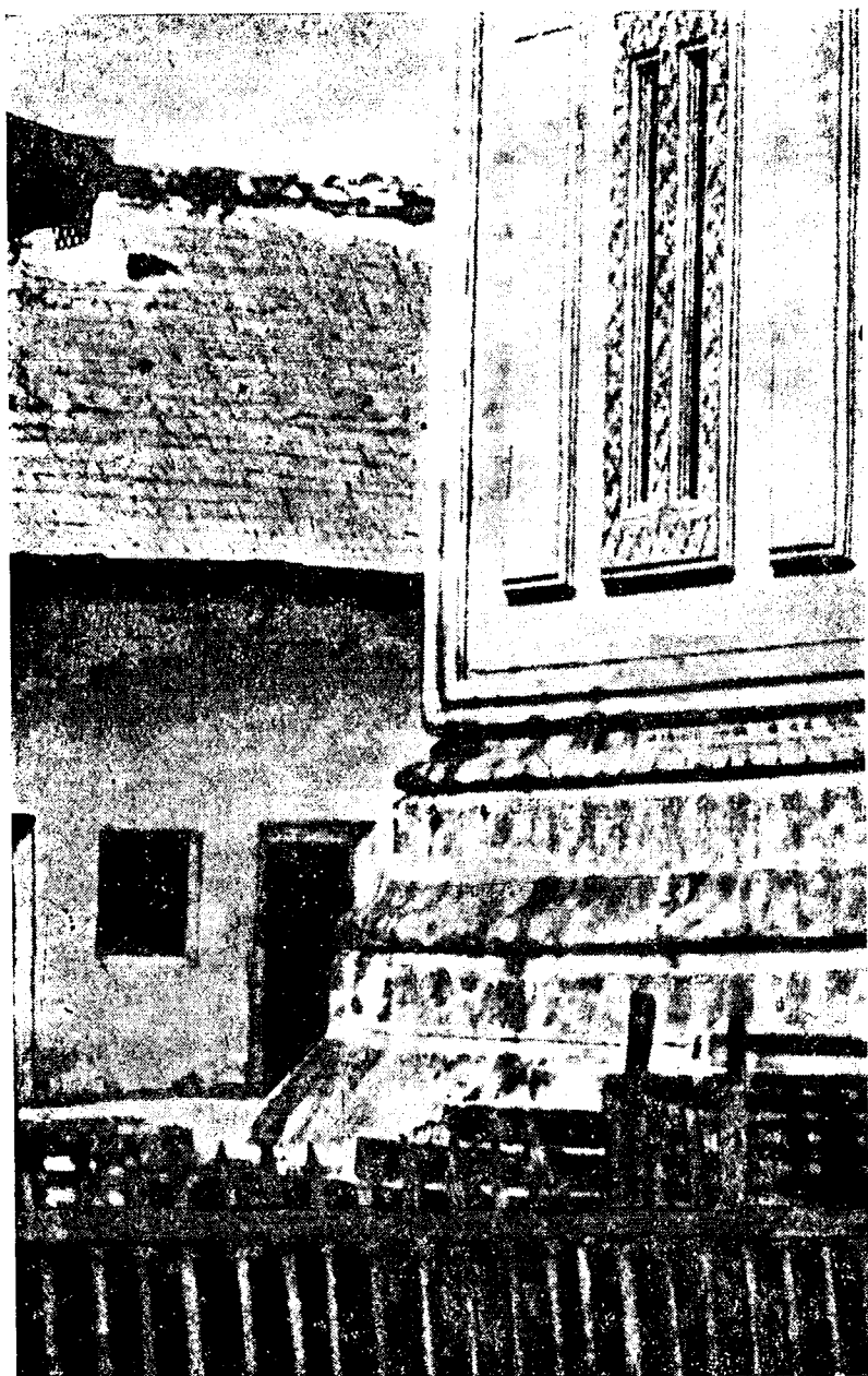
Mănăstirea Argeș. Chilie din latura nordică. Fotografie de Carol Popp de Szathmáry (După Albumul național ) [art.: Etape de construcție... ]
