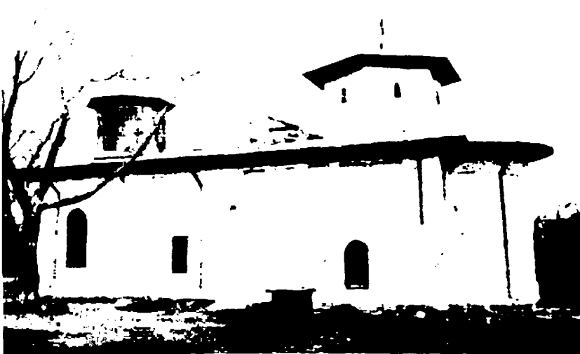
Fig. 1 – Fațada de sud a bisericii „Sf. Atanasie”, înainte de restaurare
