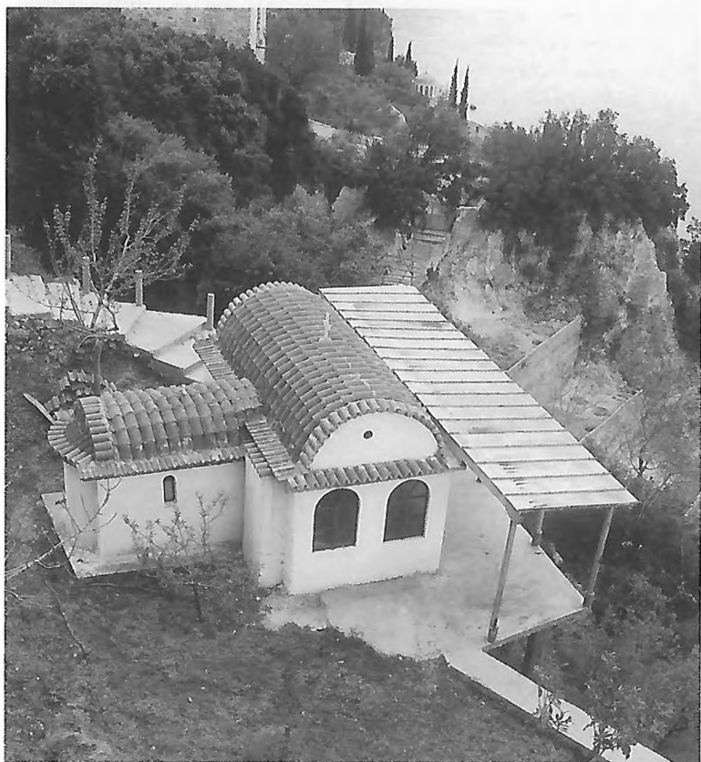
32. Vedere exterioară a mormântului lui Gheron Iosif Isihastul la Nea Skiti, după transformarea lui în paraclis.
