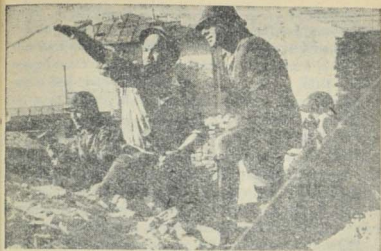
Lupta eroică a poporului nostru pentru libertate și o viață mai bună nu a putut fi stăvilită de nici o forță a burgheziei. Fotografia de față reprezintă un aspect al luptei gărzilor patriotice pentru izgonirea cotropitorilor în timpul insurecției armate din august 1944.
