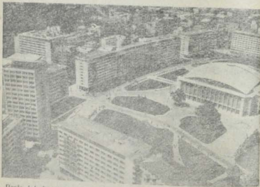
Peste tot, în orașele și satele patriei se construiesc într-un ritm rapid locuințe moderne și confortabile pentru oamenii muncii. (În fotografie: Noile blocuri și sala Palatului R.P.R. construite recent în București.)
